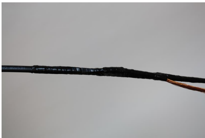
Liitoskohta suojattuna vulganoituvalla teipillä ja eristysnauhalla
