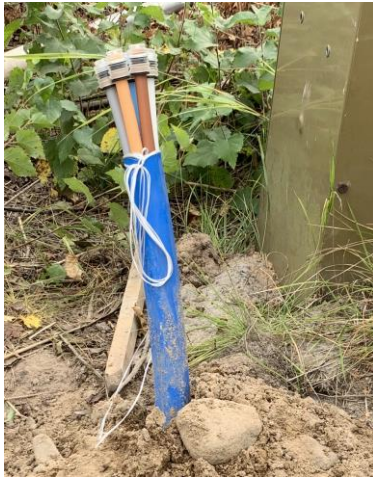
Sulje mikrokanavien päät oikeaoppisesti sulkuliittimillä.
